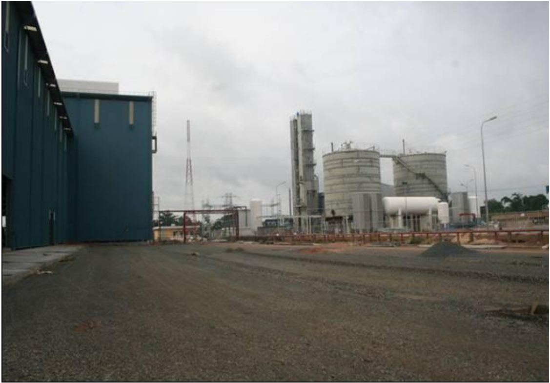
Hình 25: Nhà máy sản xuất Oxy
