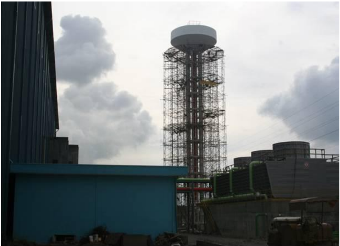
Hình 24: Khu vực xử lý nước
