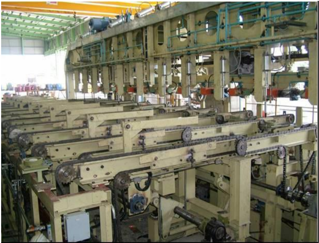
Hình 15: Dàn xếp thép hình và thanh (STACKER) của SIMAC
